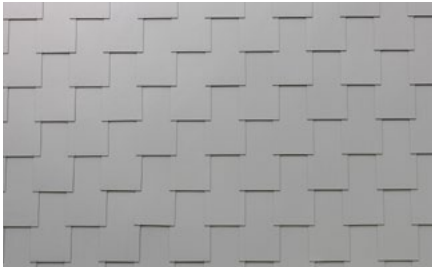
Krycie podwójne z zakładem bocznym
