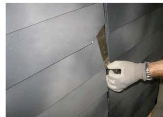
Faire glisser le tire-clou au niveau du clou de l'ardoise pour qu'il vienne se crocheter dans l'encoche.
