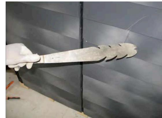
1<sup>ère</sup> étape : retirer les clous des ardoises Vertigo à l'aide d'un tire-clou.
