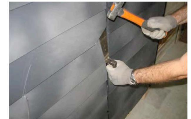
Une fois le tire-clou positionné au niveau du clou de l'ardoise, retirer le clou à l'aide d'un marteau.
