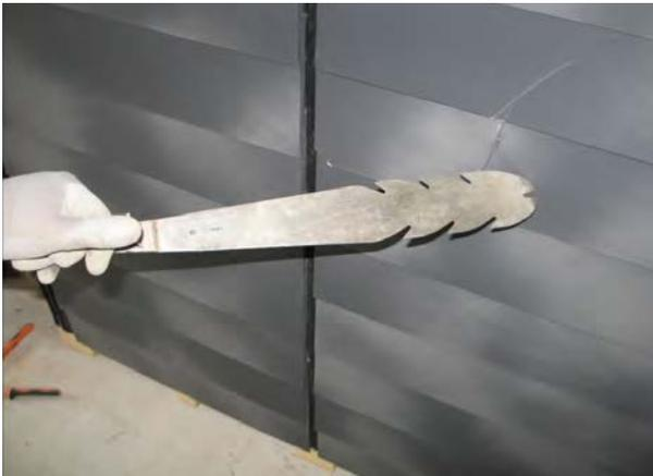
**1<sup>ère</sup> étape :** retirez les clous des ardoises Vertigo à l'aide d'un tire-clou.
