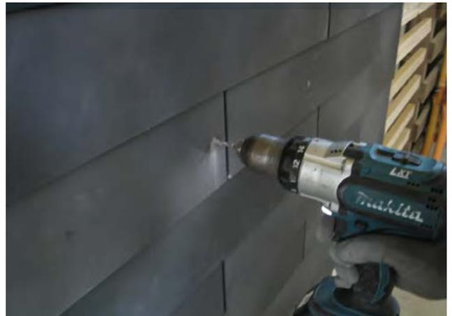
Pré-percez l'ardoise au niveau du liteau avec une perceuse (foret diamètre 4 mm) et mettez les clous apparents.
