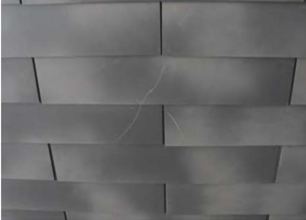
Remplacement de 3 ardoises Vertigo détériorées.
