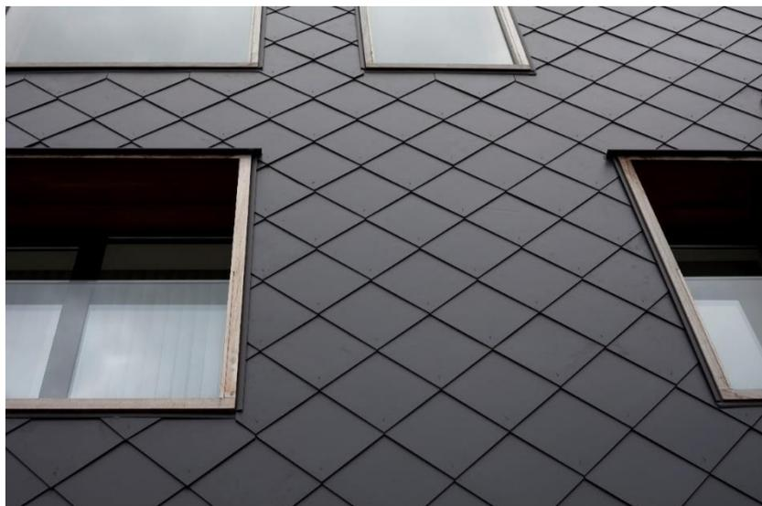
Photo 1: Pose des ardoises losanges 40/40/10 à damiers
