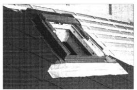
Photo 6: Pose d'une fenêtre de toiture sur des ardoises losanges
