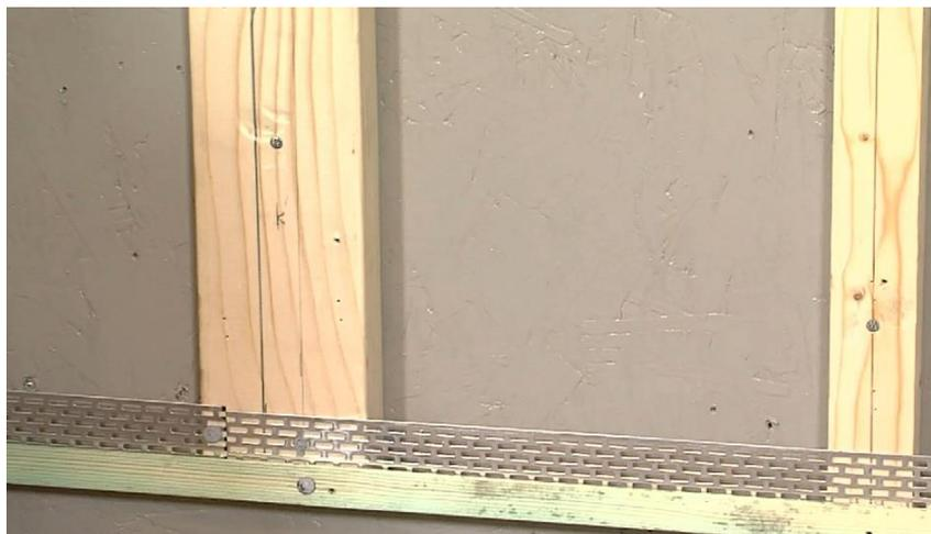
Photo 1: Bas de façade – pourvu d'un profil perforé et une latte amincie
