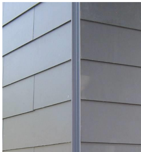
Foto 1: Voorbeeld van een afwerking van een buitenhoek (voorbeeld met halfsteensverband)
