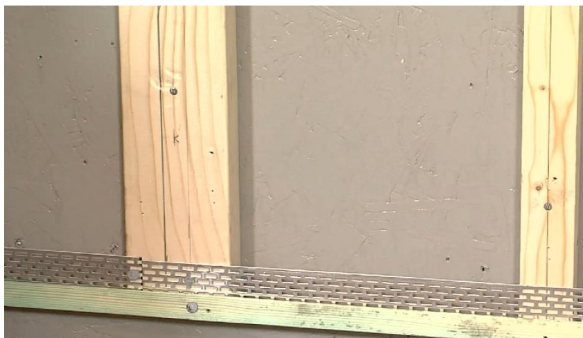
Foto 1: Onderkant gevel – voorzien van een geperforeerd sluitprofiel en een verdunde lat
