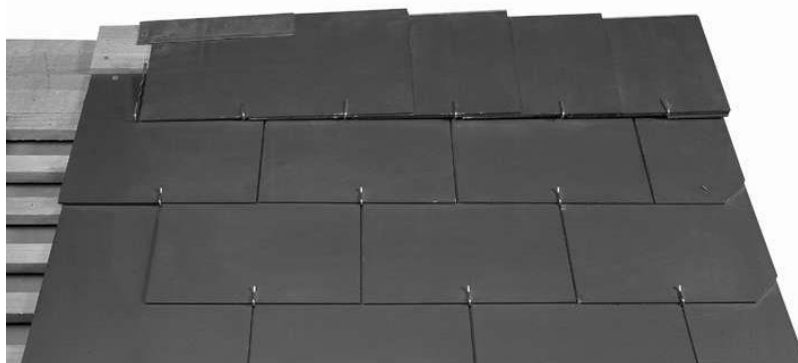
Foto 3: Nok in Strackort-afwerking
