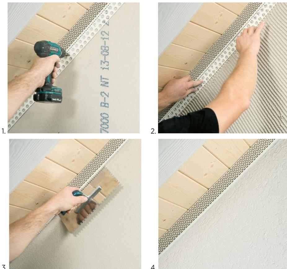
Das System-Putzabschlussprofil mit Edelstahlschrauben (z.B. Würth Assy Plus A2, 3,0 x 20) alle 40 cm in die Bluclad Putzträgerplatten verschrauben (Bild 1) (Zimmermann/Holzbauer). Alternativ, wie in Bild 2 dargestellt, im Zuge der Beschichtungsarbeiten in den noch feuchten Unterputz einbetten (Maler/Putzer).
