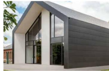
Pose horizontale à recouvrement double
