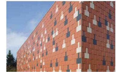
Pose inclinée à recouvrement double
