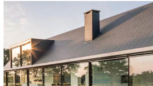
Das sehr leicht, fast schwebend wirkende Dach ist mit dunklen Faserzementplatten gedeckt, deren glatte Oberfläche einen schönen Kontrast zu den großen Glasflächen bildet.
