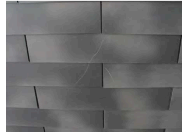
Remplacement de 3 ardoises Vertigo détériorées.
