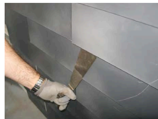
Faire glisser le tire-clou au niveau du clou de l'ardoise pour qu'il vienne se crocheter dans l'encoche.
