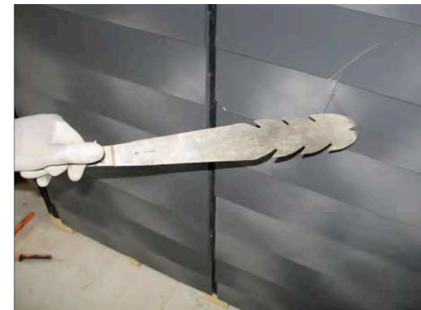
1 ère étape : retirez les clous des ardoises Vertigo à l'aide d'un tire-clou.
