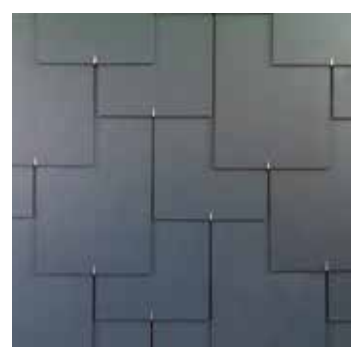
Pose en escalier
