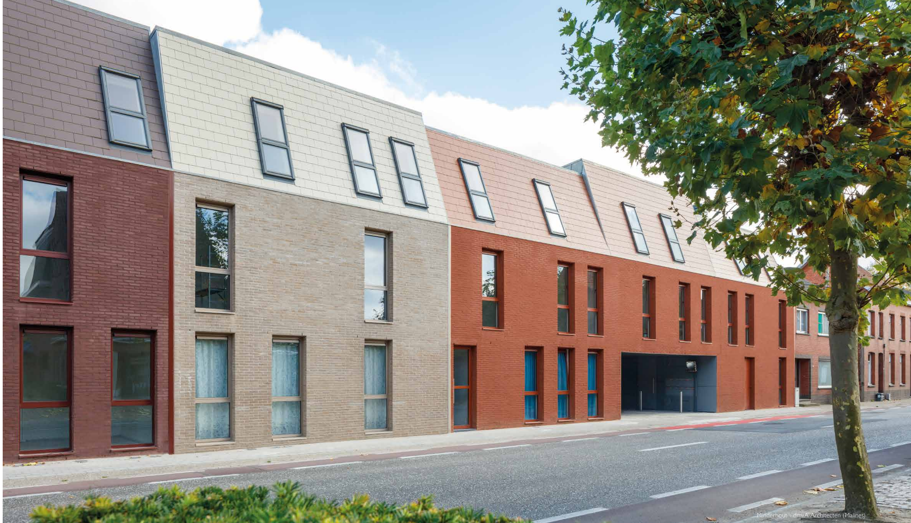
Minderhout - dmvA Architecten (Mechelen)
