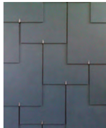
POSE EN ESCALIER
